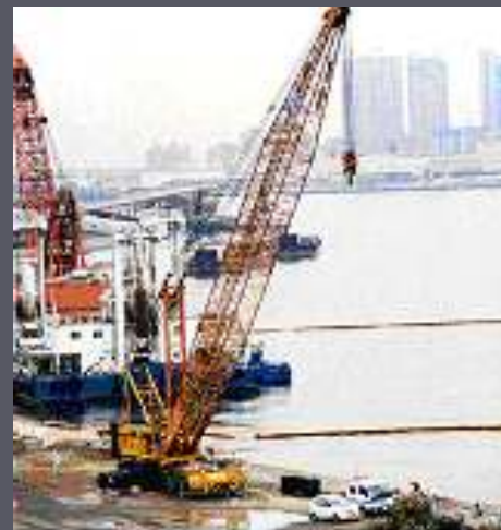
クローラクレーン(Lattice Boom Crane)
